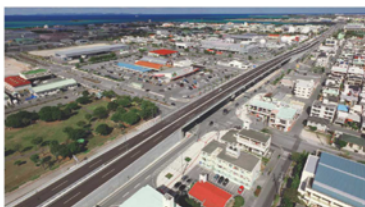
全線完成開通した糸満道路
