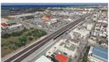
全線完成開通した糸満道路
