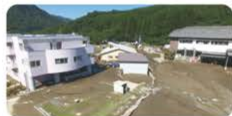
H28台風10号で被災した高齢者福祉施設 (国土地理院撮影)
