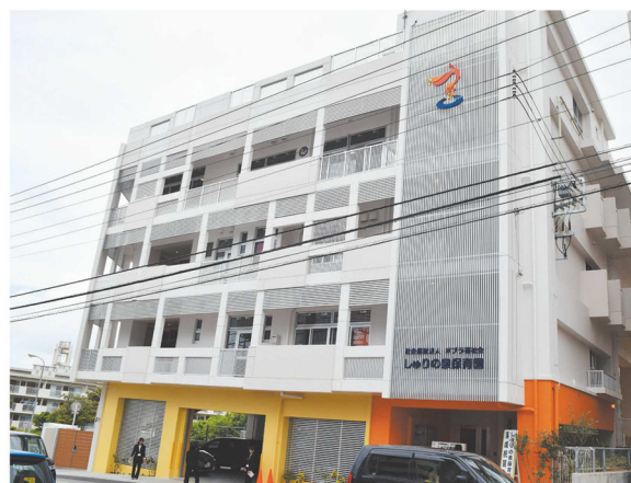
完成した新園舎
