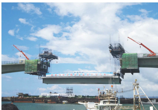
架設中の状況（平成29年8月28日撮影）
