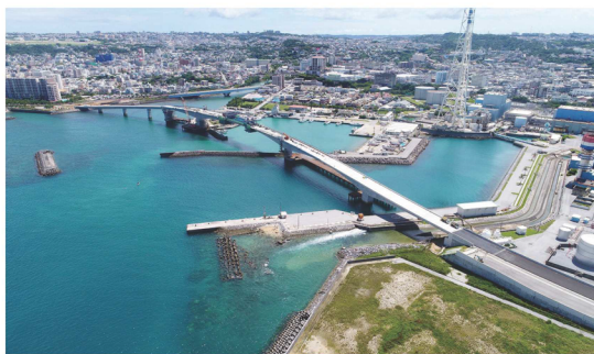
工事中の浦添北道路（牧港高架橋）
