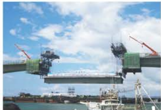
架設中の状況（平成29年8月28日撮影）
