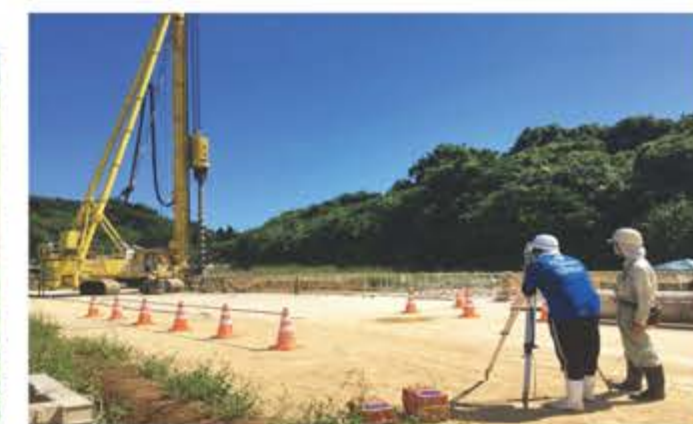
地下ダム工事現場での測量体験実習の様子
