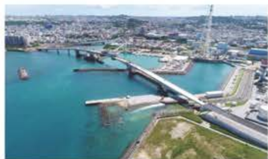
工事中の浦添北道路（牧港高架橋）
