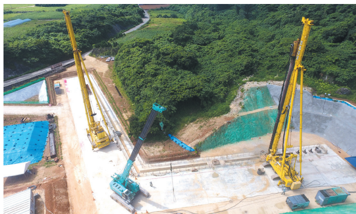
地下ダム止水壁の施工状況
