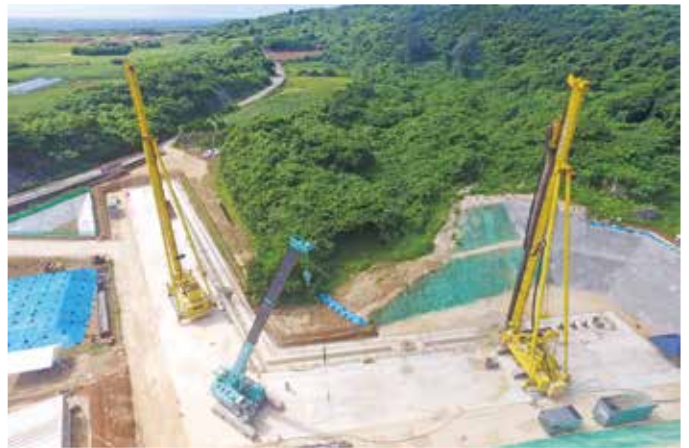
地下ダム止水壁の施工状況
