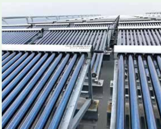
↑屋上に設置された太陽熱温水器
