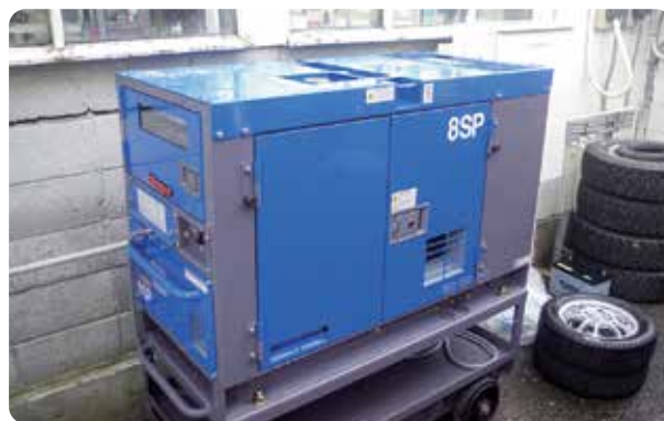
令和元年台風第15号(房総半島台風)の際に、SSの配電盤につないだ自家発電設備(千葉県鴨川市) (出典:資源エネルギー庁ウェブサイト)
