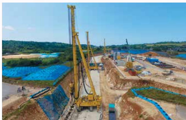
地下ダム止水壁の施工状況（宮古島市）
