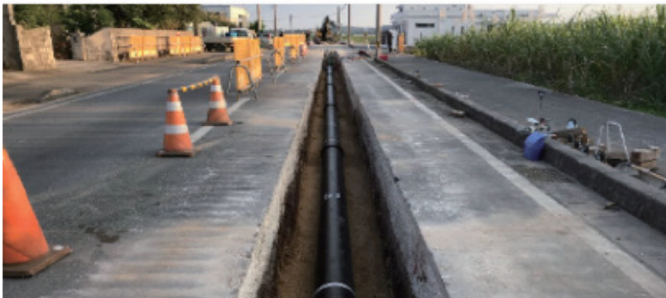
ダクタイル鋳鉄管への改修工事の様子
