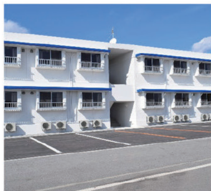
完成した季節労働者等の宿泊施設
