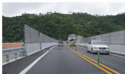
▲開通状況(数久田高架橋)
