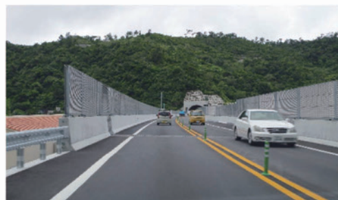
▲開通状況(数久田高架橋)
