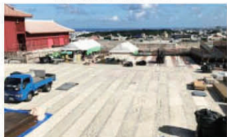
磚瓦撤去後の御庭
