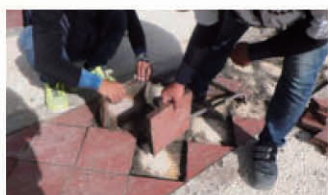
磚瓦撤去作業の様子
