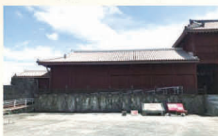
奉神門 応急復旧後
