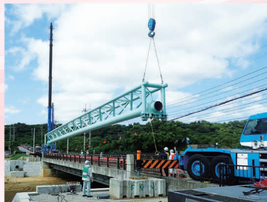
幹線水路の施工状況(石垣島)
