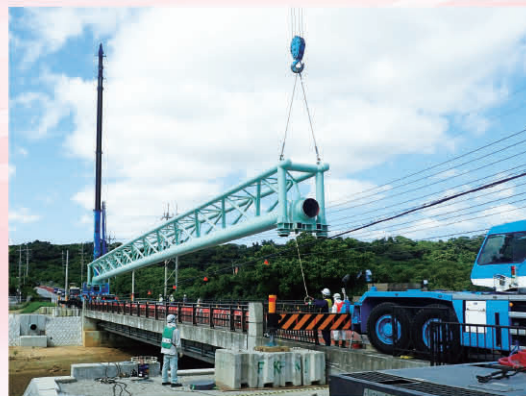
幹線水路の施工状況(石垣島)
