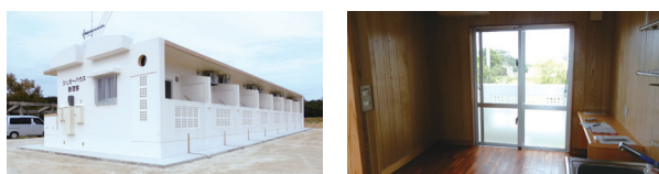
完成した宿泊施設（伊是名地区）
