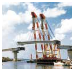
泊大橋架設(昭和60年)
