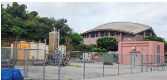
自社ホテルの温泉と、電気及びボイラー熱源(コジェネ)利用のため、水溶性天然ガスを採掘
