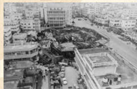
昭和48年11月26日。琉海ビル陥没事故。(沖縄建設新聞所蔵)。那覇市前島の建設現場で大規模な道路陥没事故が発生。長さ約100m、幅約50mにわたる大規模なもので、国道も1車線の幅を残すのみとなり、周囲のアパートや民家、駐車中の乗用車約10台が転落した。
