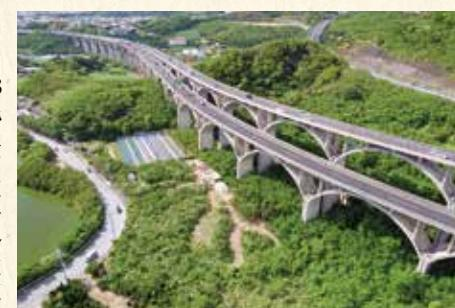
平成12年6月28日、九州・沖縄サミットに先立ち那覇空港自動車道南風原道路が開通。その南風原道路の一部を構成する南風原アーチ橋は、全長828m(下り)にわたる世界有数の鉄筋コンクリート作りのアーチ橋。施工にあたっては、全アーチが閉合するまでの変位を抑制する、世界初となる斜材・セントル併用工法も採用された。
