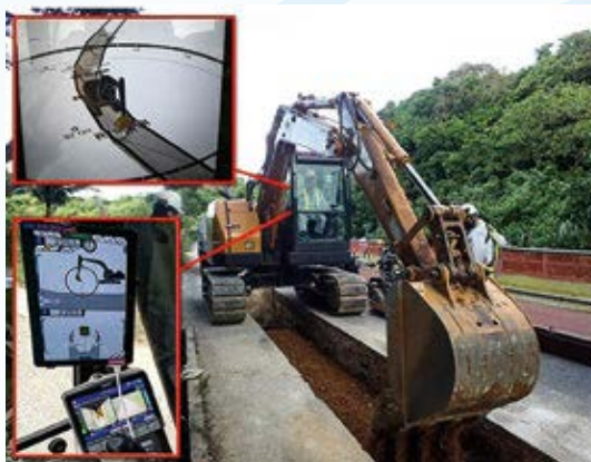
▲ICT建設機械(MG)による情報化施工(石垣島)
