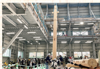
正殿の一本目の柱を吊り上げる状況(R5.9.4)
