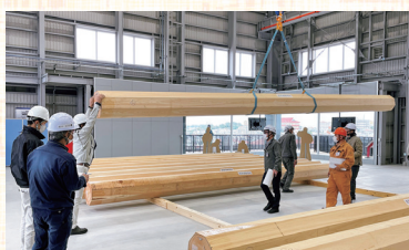
大径材（主に柱）搬入状況（県調達分）
