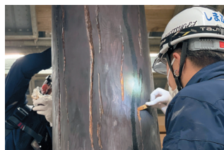
向拝柱（イヌマキ材）の 刻字（こくそ）詰め状況 (R6.2.26) ※木材のひび割れ等を埋める作業
