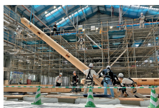
正殿軸組建方開始 (R5.9.4) ※一本目柱の吊上げ状況
