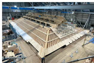
正殿屋根の木工事の状況 (R6.3.28)
