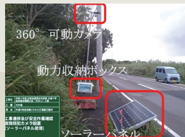
情報化施工技術 (MG バックホウ、遠隔確認自動録画システム) の活用
