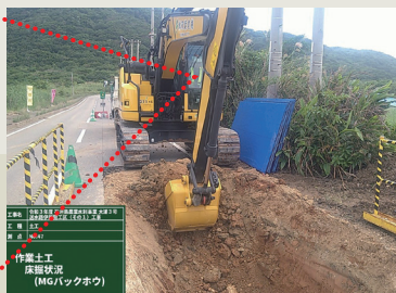
情報化施工技術 (MG バックホウ、遠隔確認自動録画システム) の活用
