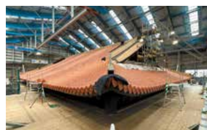
平瓦、丸瓦の設置 しっくい （漆喰下塗り中）された状況（R6.9.26）
