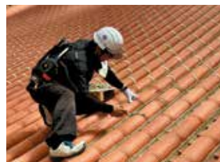
丸瓦設置後の漆喰下塗り作業の状況
