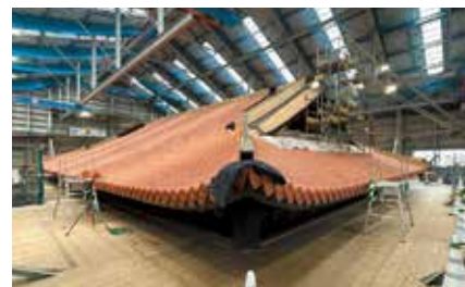
平瓦、丸瓦の設置（ しっくい 漆喰下塗り中）された状況（R6.9.26）
