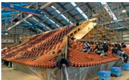
赤瓦設置開始直後（設置前の瓦が並べられた状況）（R6.7.17）
