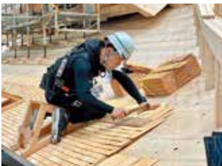
のじいた どいぶ 野地板上への土居葺き作業の状況
