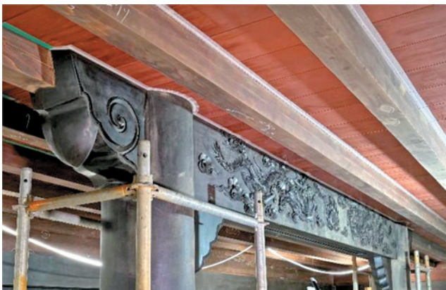
内部の進捗状況（正殿内部2階天井額木下塗：R7.7.29 撮影）
