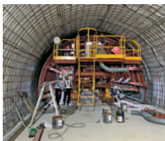
トンネル(NATM工法)
