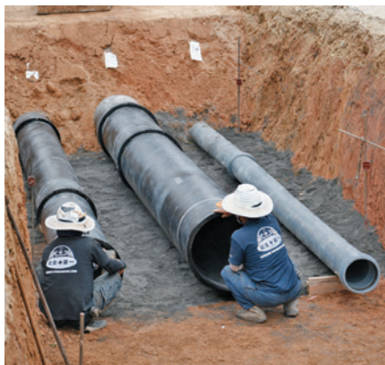
農業用水管施工状況（石垣島地区）
