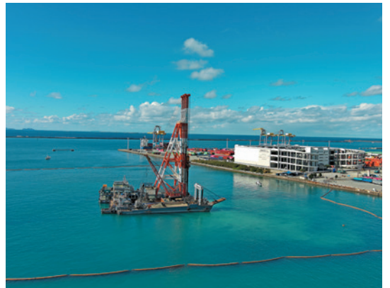
那覇港新港ふ頭地区岸壁施工状況（令和8年1月）
