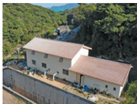
揚水機場(大浦)
