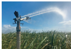
かんがい施設の整備(石垣島)
