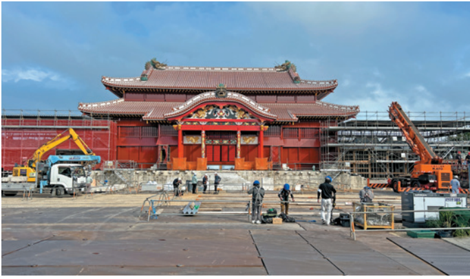
首里城正殿（向廊下施工状況）（令和7年12月）
