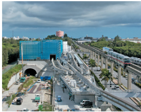
沖繩都市モノレール及び車両基地
