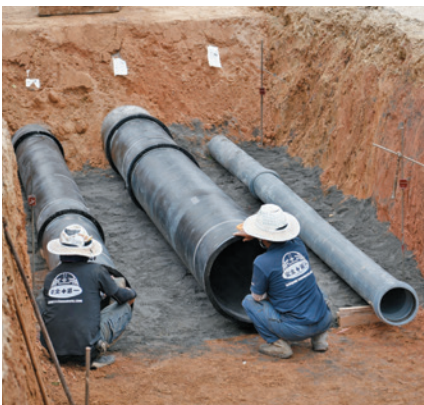
農業用水管施工状況（石垣島地区）
