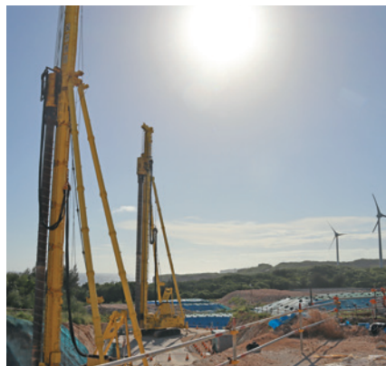
保良地下ダム施工状況（宮古伊良部地区）
