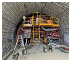
トンネル(NATM工法)
