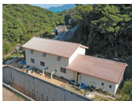
揚水機場(大浦)
