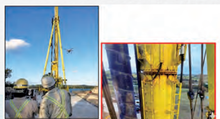
前田・共和 JV 施工機械の点検の様子
