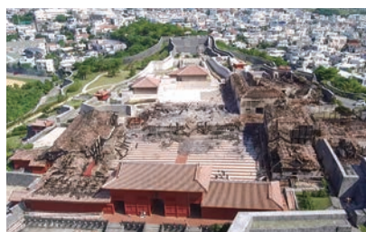
火災後の首里城(令和元年11月1日時点)
