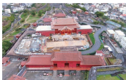
復元工事中の首里城(令和8年2月9日時点)
