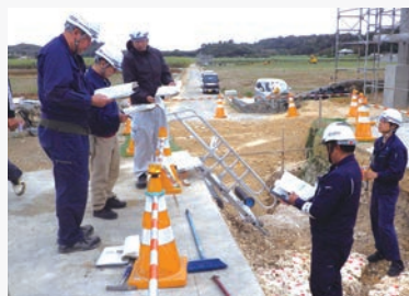
現場での土質調査状況
