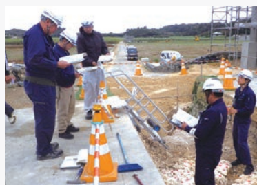
現場での土質調査状況
