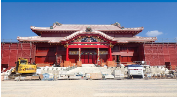
首里城正殿復元整備工事 国営沖縄記念公園 首里城地区
