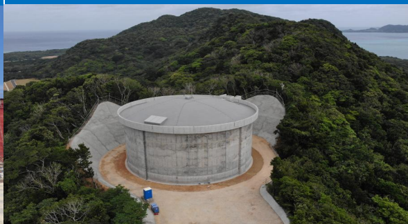
国営かんがい排水事業 大浦一号配水池（石垣市）
