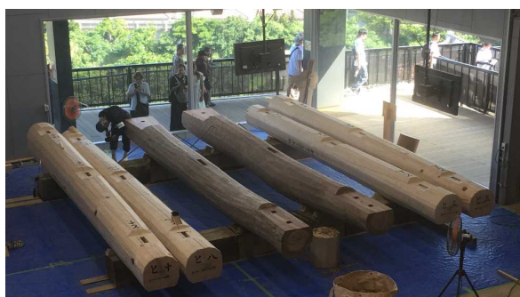
木材倉庫・原寸場見学エリア(内部より撮影) (小屋丸太梁加工状況 内側の2本はオキナワウラジロガシ)
