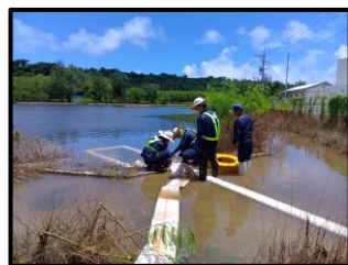
冠水箇所の吸い込み口設置
