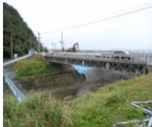
応急組立橋の設置状況
