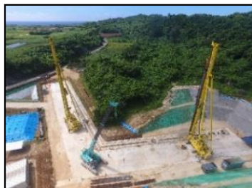
地下ダム止水壁の施工
