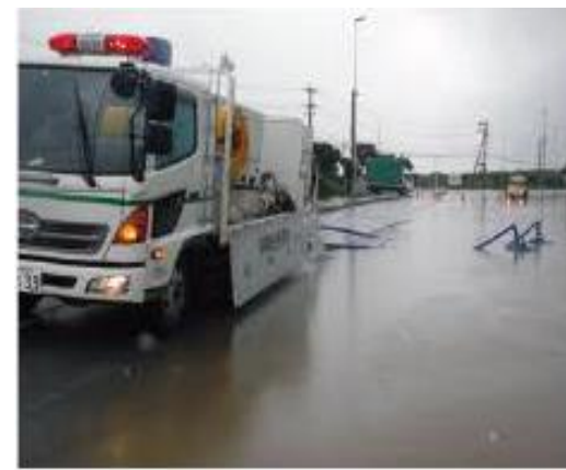
排水ポンプ車による応急復旧
