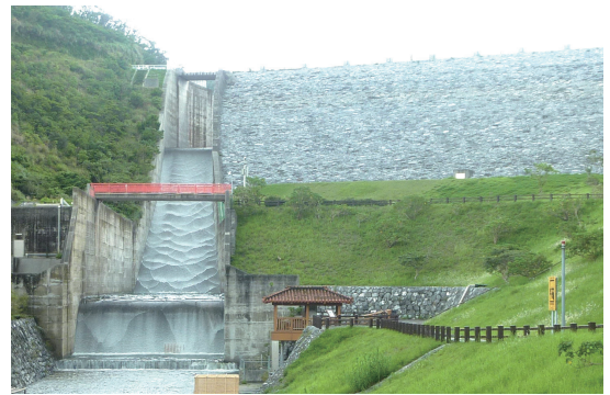
[ 羽地ダムを下からみた写真 ]
