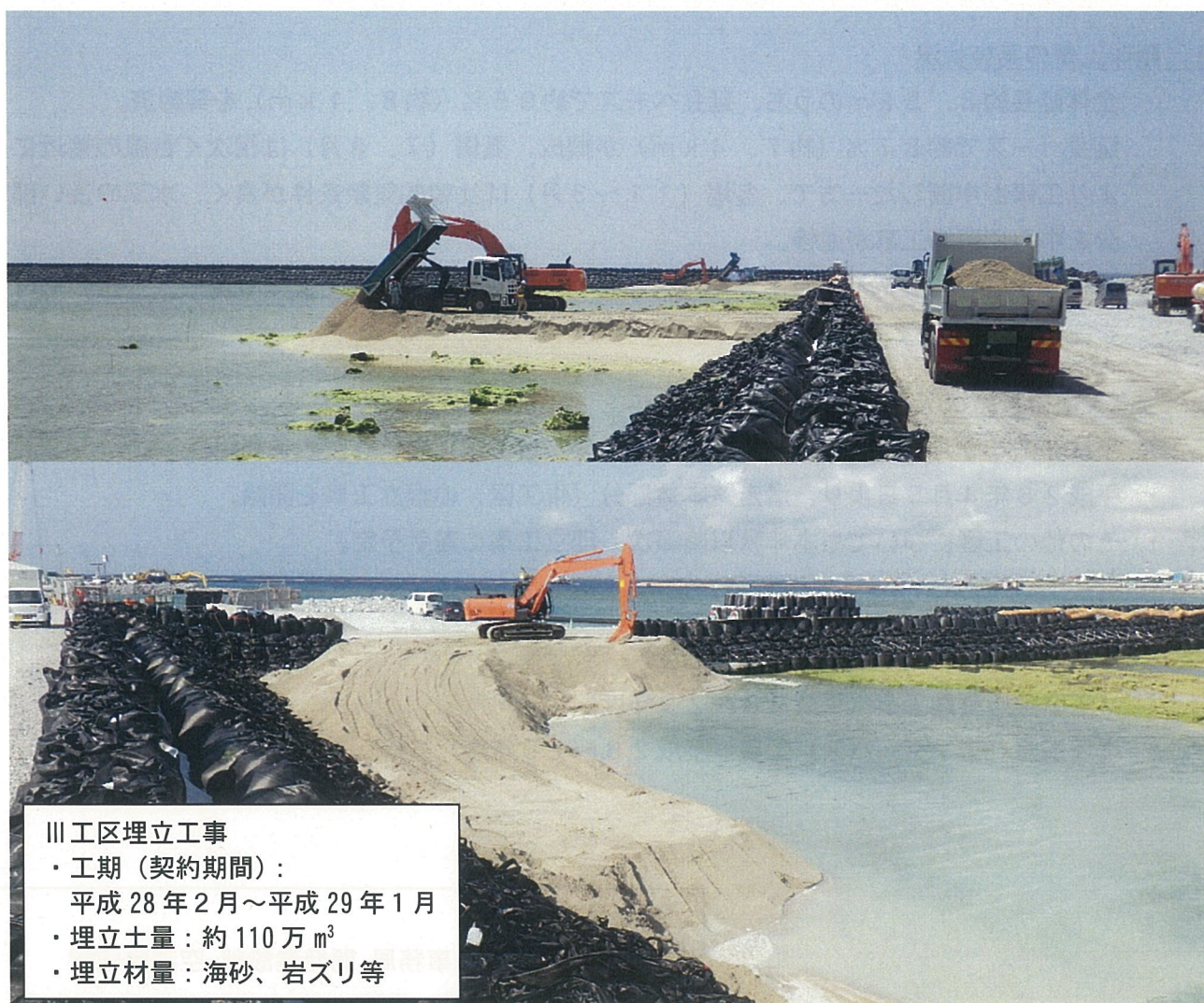
III工区埋立工事の実施状況
