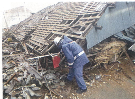
被災状況調査班（建築物判定）の様子 （応急危険度判定）
