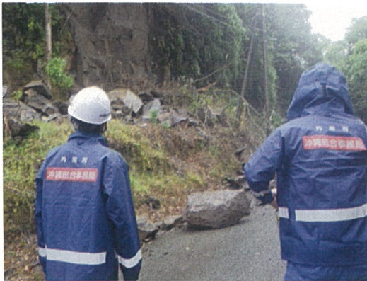
被災状況調査班（砂防）の様子 （土砂災害危険箇所点検）
