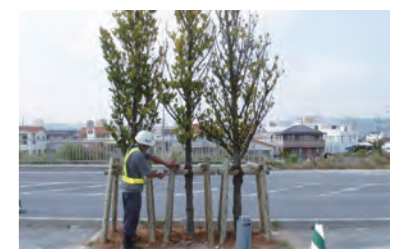
写真7 支柱の設置(風等による倒木等を防止)
