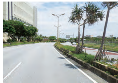
写真1 景観の統一性に欠ける状況(右手歩道部樹木の伐採や中央分離帯の樹木の樹形の乱れ)
