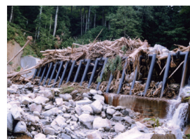
流木捕捉式治山ダム
