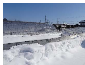
農業用ハウスの損壊（福井県）
