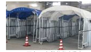
写真2-5.仮設移動式通路
