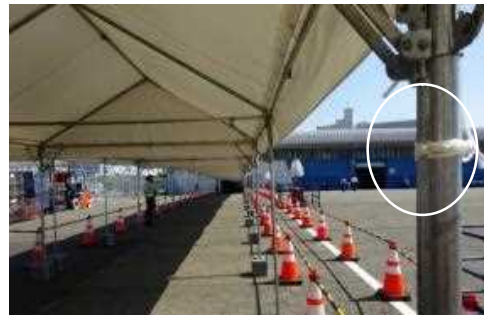
写真 1-34. テント同士をロープで連結
