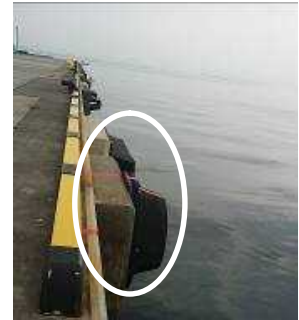
写真 2-28. 船側の要望に応じて整備した接岸部の防舷材
