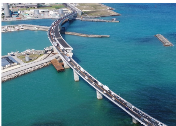
▲開通後の状況(浦添北道路)
