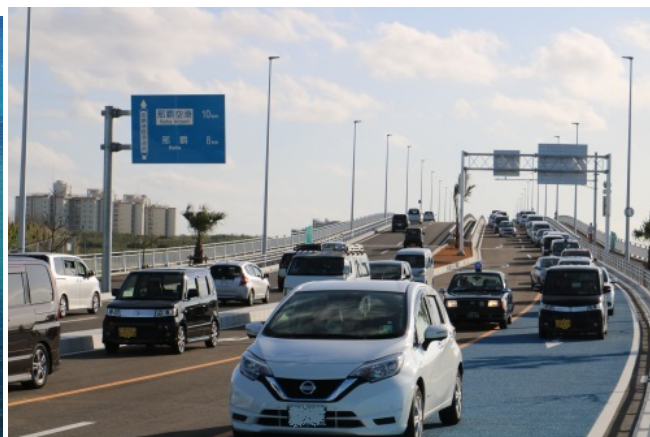
▲開通後の状況(臨港道路浦添線)
