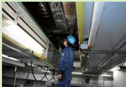
下廻り検査(ビット方式) ピット内部
