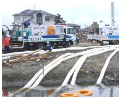
排水ポンプ車による活動状況
