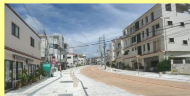
琉球石灰岩を用いた歩道と路肩
