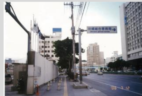
電線共同溝事業：那覇市(一般国道58号)
