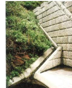
漢那ダム魚道
