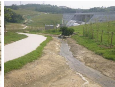
金武ダム魚道
