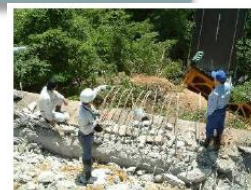
被災状況調査(現地調査)
