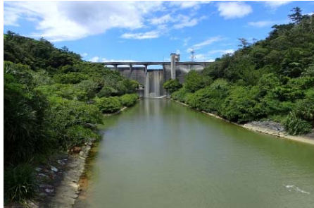
漢那ダム本ダム堤体
