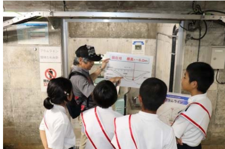
漢那ダム監査廊
